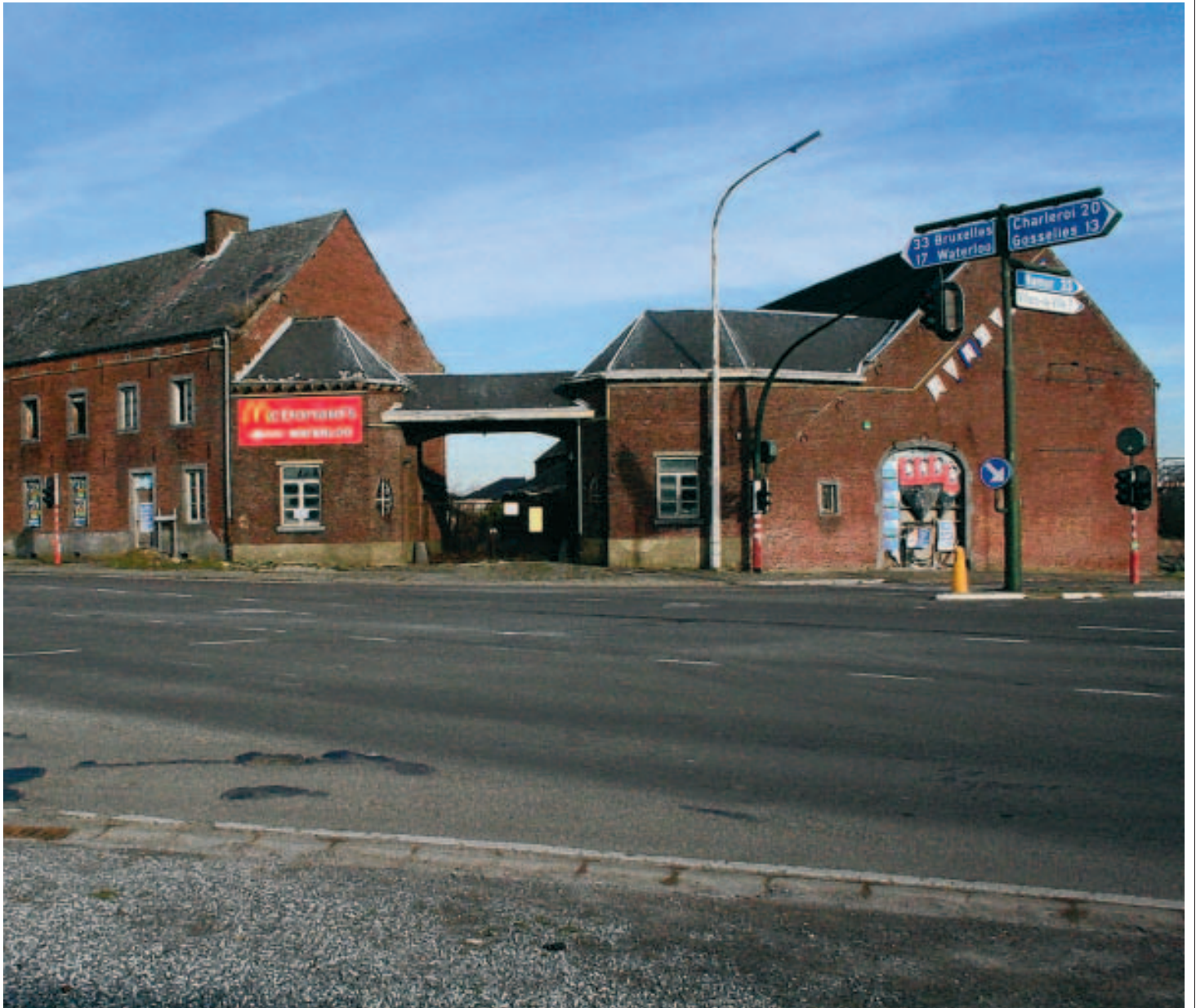
La ferme, transformée en discothèque à une époque, est à l'abandon depuis des années.
