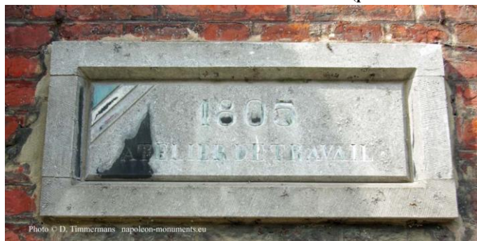
1805 ATELIER DE TRAVAIL, (façade latérale du musée) avant...
