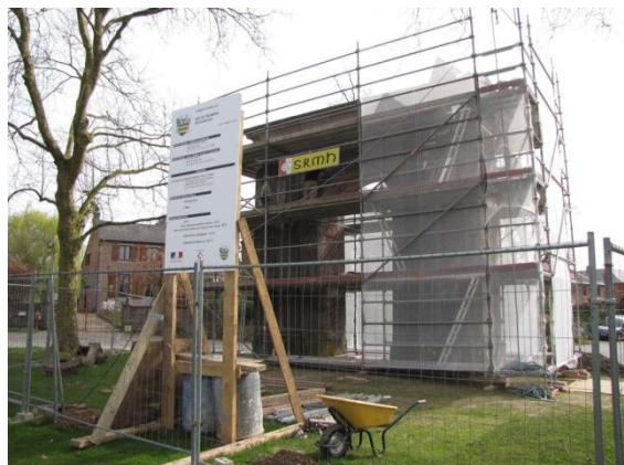
Travaux en cours...
